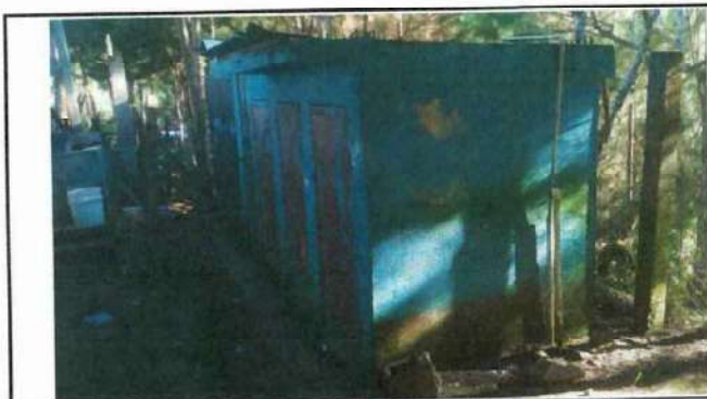
Foto 6: el estado actual del modulo de 6 bañoso esta dañado, esta inclinado y ya no esta a nivel por tal motivo es necesario la rehabilitacion de las paredes.
