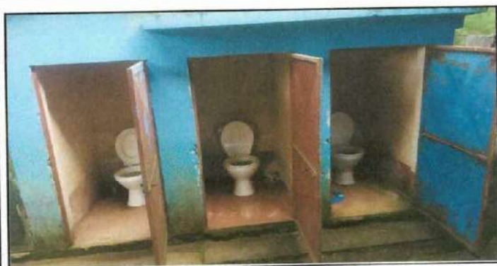
Foto 5: las puertas de los baños ya estan en muy mal estado como tambien los inodos, por tal motivo es necesario el mantenimiento a puertas y cambio de inodoros.
